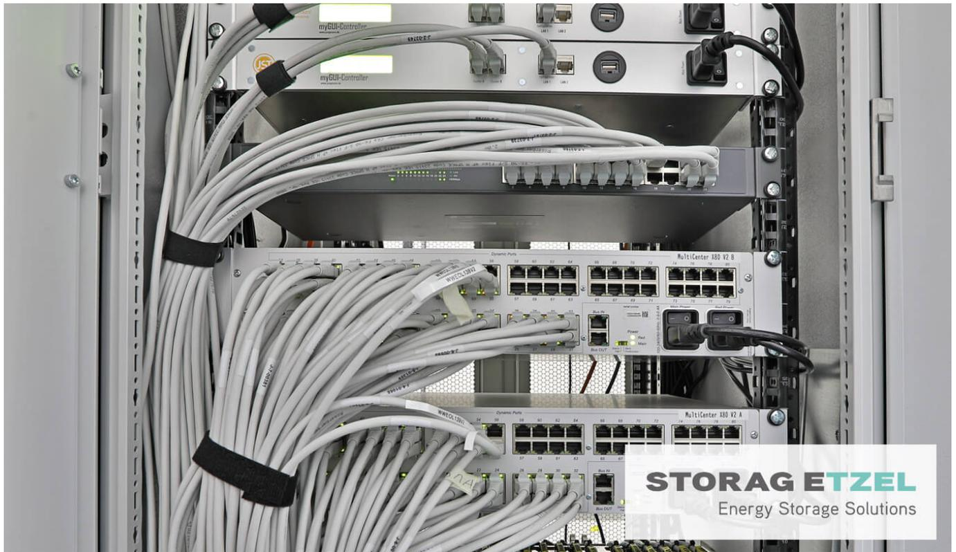
Redundanz für maximale Sicherheit auf dem Gelände der Kavernenspeicheranlage von STORAG ETZEL im niedersächsischen Friedeburg. Bei den unteren beiden Komponenten handelt es sich um die MultiCenter für die Kontrollraumsteuerung mit MultiConsoling® – hier in zweifacher Ausführung für maximale Sicherheit.
