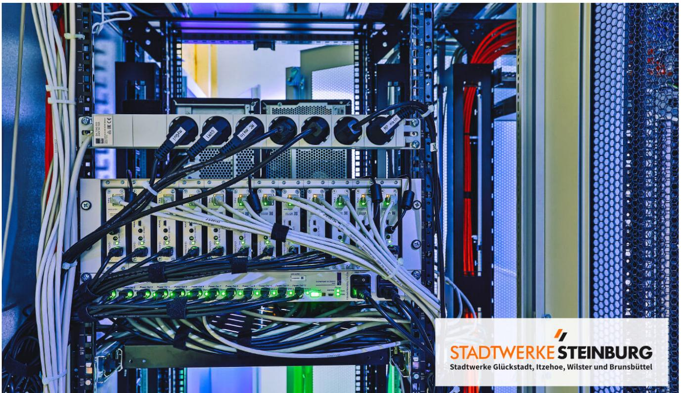
Der Blick in den Technikraum der Stadtwerke Steinburg offenbart einige der Hardwareelemente für das JST Bedienkonzept MultiConsoling<sup>®</sup>: Grabber mit zugehöriger Power Unit. Da die einzelnen Komponenten dank des MultiConsoling<sup>®</sup> ausgelagert werden können, reduziert sich Belastung durch Wärme und Geräusche im Kontrollraum deutlich.
