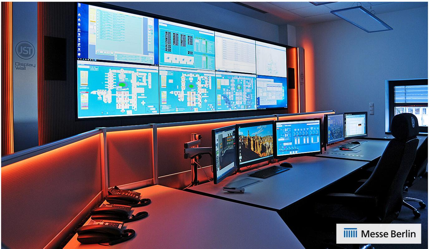
Lüftungsanlagen fallen aus, einer der rund 100 Aufzüge bleibt unbemerkt stecken – modernste Sicherheitstechnik macht es auf dem Gelände der Messe Berlin GmbH möglich, solchen Szenarien präventiv zu begegnen. Mit den eingesetzten JST Komponenten verfügen die Mitarbeiter der Leitstelle über ein sicheres und proaktives Alarmmanagement.
