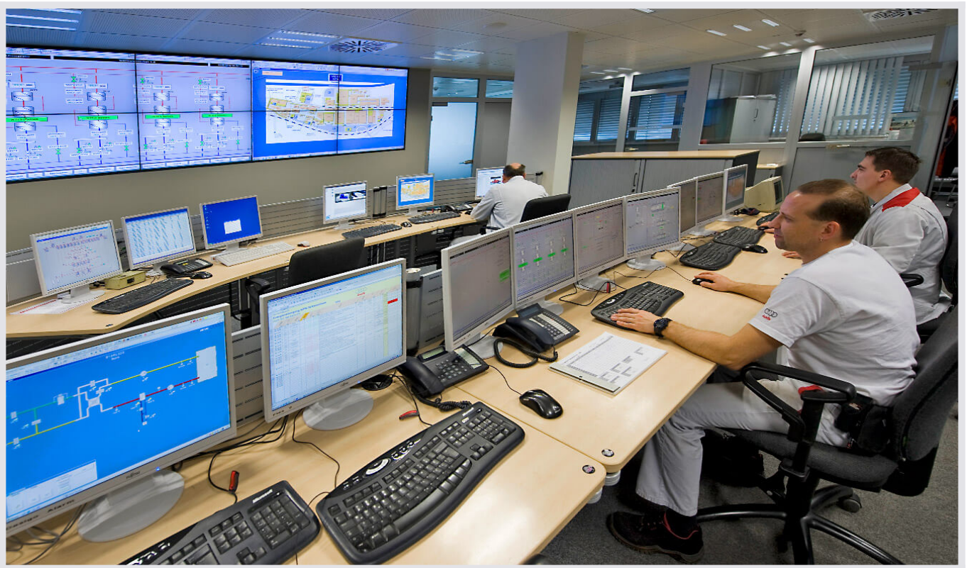
Audi Neckarsulm: Zentrale Leitwarte saniert
