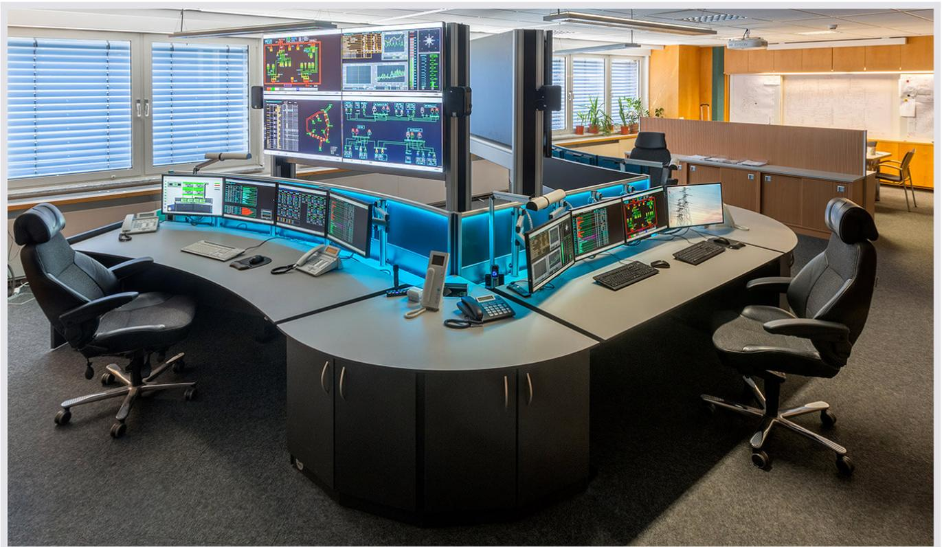
JST Leitstand-Konzept: Blick in die neue Netzleitstelle. Ein innovatives technisches Konzept wird von optimierter Visualisierung und ergonomischem Mobiliar ergänzt.
