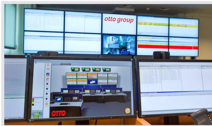
**JST Leitwartentisch:** Eine spezielle Lösung im Leitstand der Otto Group – die Arbeitsplatzdisplays befinden sich auf einer höhenverstellbaren Monitaraufstellfläche, die ganz nach Belieben hoch gefahren und selbstverständlich auch abgesenkt werden kann.
