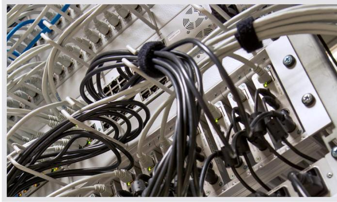
**JST MultiConsoling®:** Blick auf die Technik für die Bedienoberfläche myGUI – im oberen Teil des Bildes befindet sich das MultiCenter, darunter die Grabber, an denen die einzelnen Rechner angeschlossen und so mit dem MultiCenter verbunden sind.
